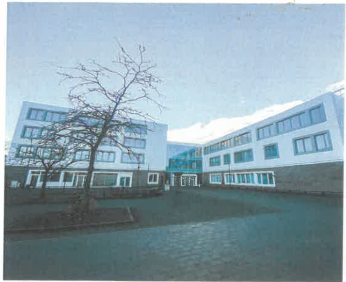
Im Fokus der Solar-Initiative Halstenbek. Das Dach des Wolfgang-Borchert-Gymnasiums.
